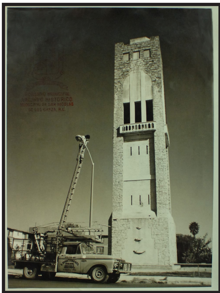
Cambio de luminarias frente a la Torre de la Anáhuac durante la presidencia municipal del Ing. Luis J. Prieto (1974–1976) Fuente: Archivo Histórico de San Nicolás.
